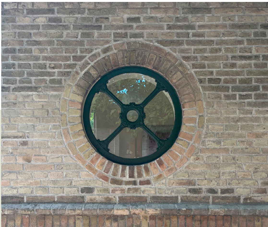
Sønderport, vindue mod nord efter istandsættelse. Foto: Cornelius Vøge.
