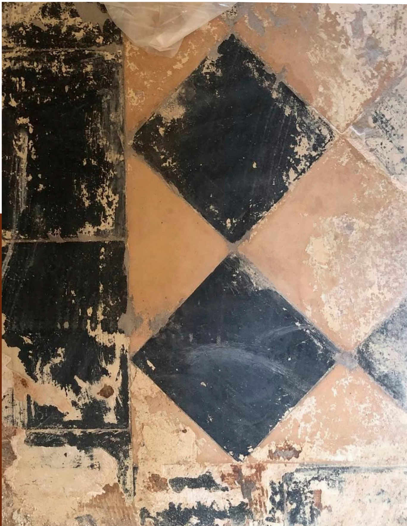
Sønderport, flisegulv under afrensning. Foto: Cornelius Vøge.
